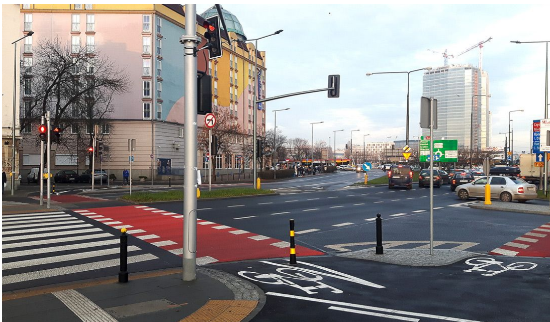
Rys. 2. Skrzyżowanie ul. Raszyńskiej i ul. Koszykowej, przejazd rowerowy przez ul. Raszyńską, widok w kierunku północno-zachodnim.
