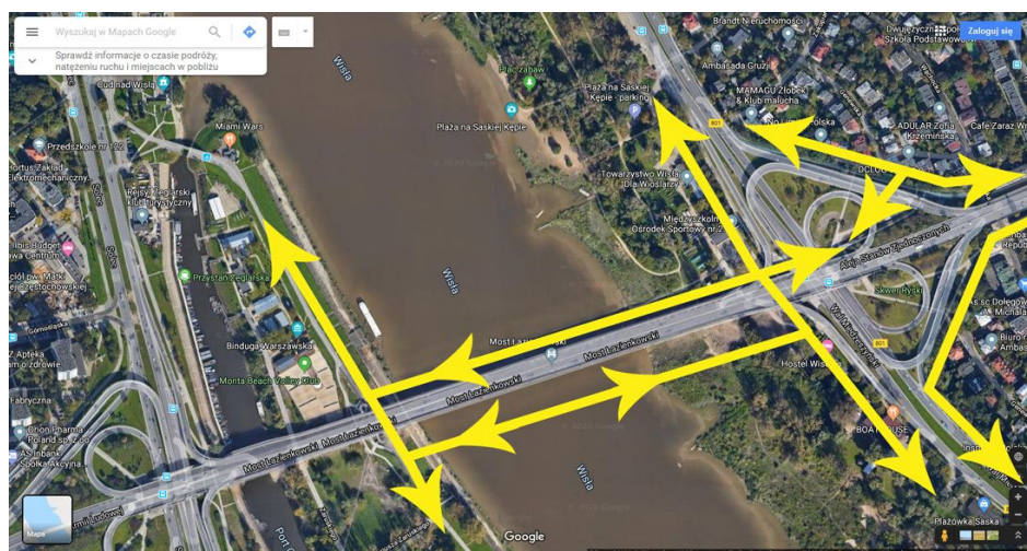
Rys. 2. Infrastruktura rowerowa na moście Łazienkowskim (podwieszona do mostu kładka) i w jego okolicach (zdjęcie satelitarne):
